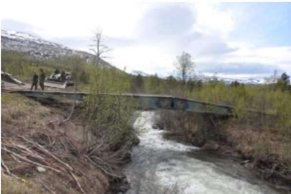
Kobbryggelva, utlegging av midlertidig bru
