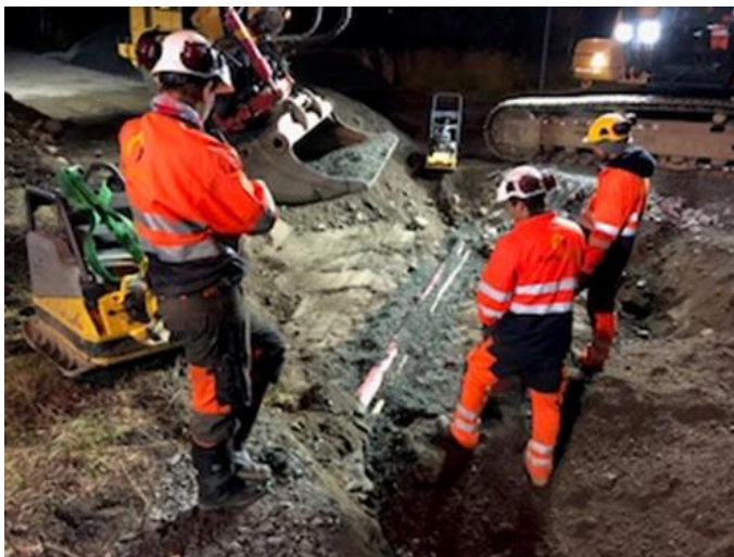
Nattarbeid med å skifte vannrør under E6
