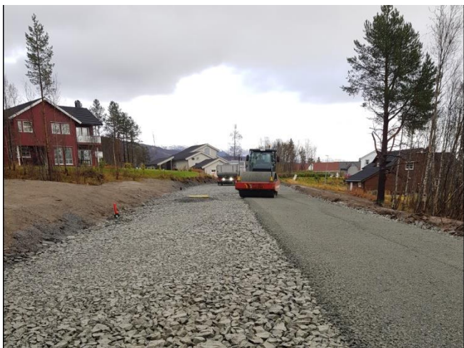
Kirkemo 3, byggetrinn 1 klargjort for bygging
